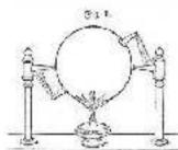
Um 100 vor Christus baute der Grieche Heron von Alexandria einen Dampfball und stellte an dem Experiment fest, dass sich die Kraft des heißen Wasserdampfes so in Bewegung umsetzen lässt; eine Art Düsenantrieb. Diese Erfindung als Vorläufer der Dampfmaschine hat bereits vor 2000 Jahren stattgefunden.
